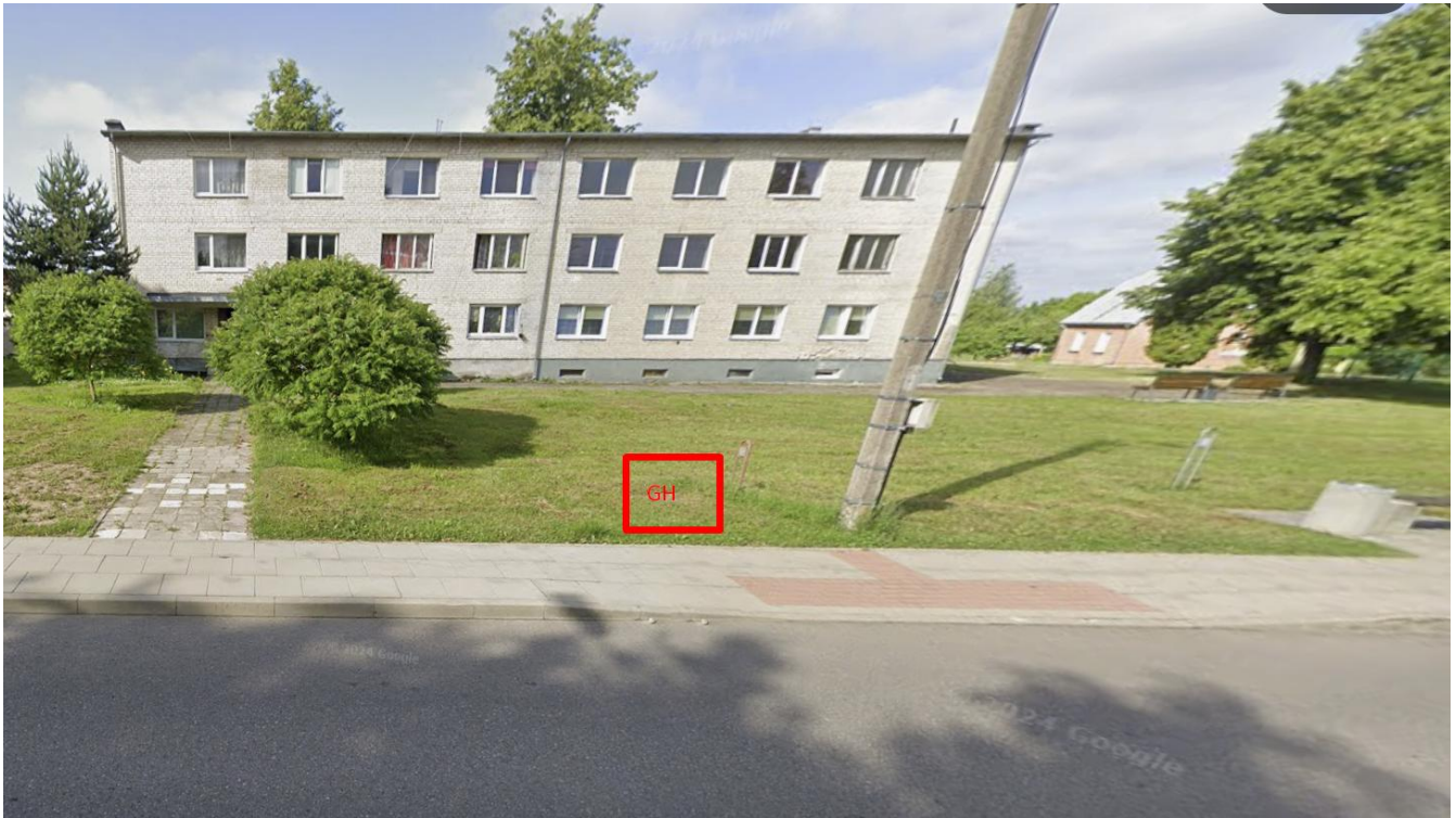
1 pav. Artimiausio požeminio gaisrinio hidranto vieta tiesiai priešais projektuojamą pastatą.
